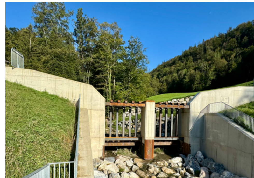
Der Leube GreenTech KOMBI ZEMENT ist auch für extreme Herausforderungen geeignet, wie der Schutzbau der Sperre Kleinkirchentalgraben in Hallein beweist.
