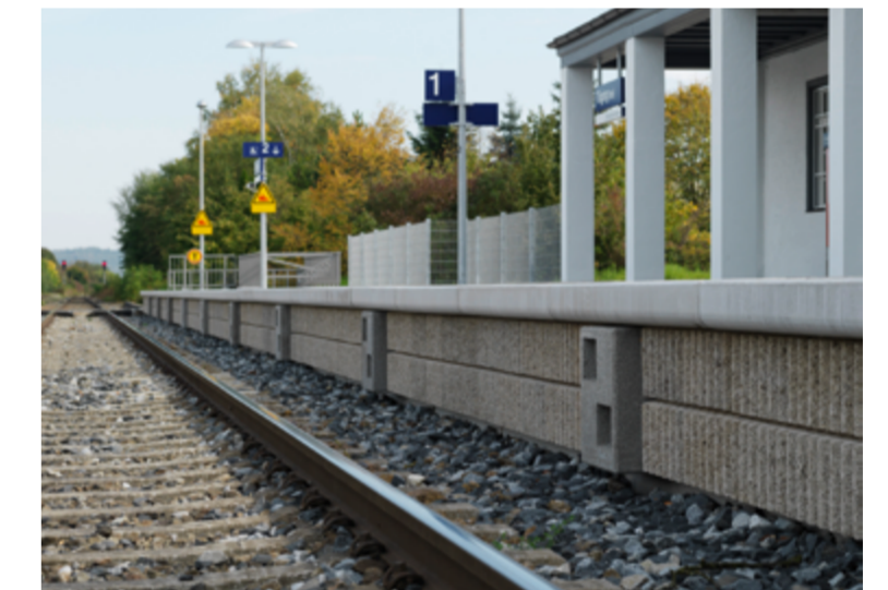
Hochabsorbierende Bahnsteigkante, SOB Töging, DE.
